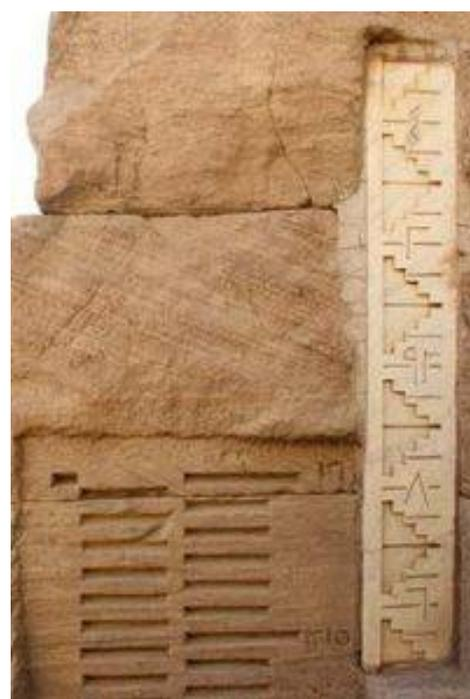
La numérotation d'origine dans les escaliers du nilomètre de Satet est encore visible avec des caractères grecs doublés de chiffres arabes du 19<sup>e</sup> siècle et une échelle métrique moderne sculptée dans des éléments en marbre.
